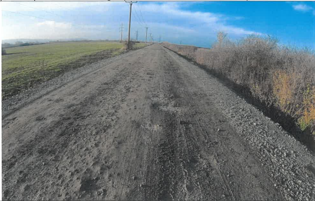
Foto 2: Drumul Național DN 28G km 17+674 – 19+695 – Pe sectorul analizat se constată prezența unui strat rutier din piatra sparta neuniform, cu tasări locale, denivelări longitudinale material granular dispersat pe acostamente. Pe partea dreapta se evidenziază o vaioaga ce prezintă diferențe de nivel semnificative raportat la calea de rulare.
