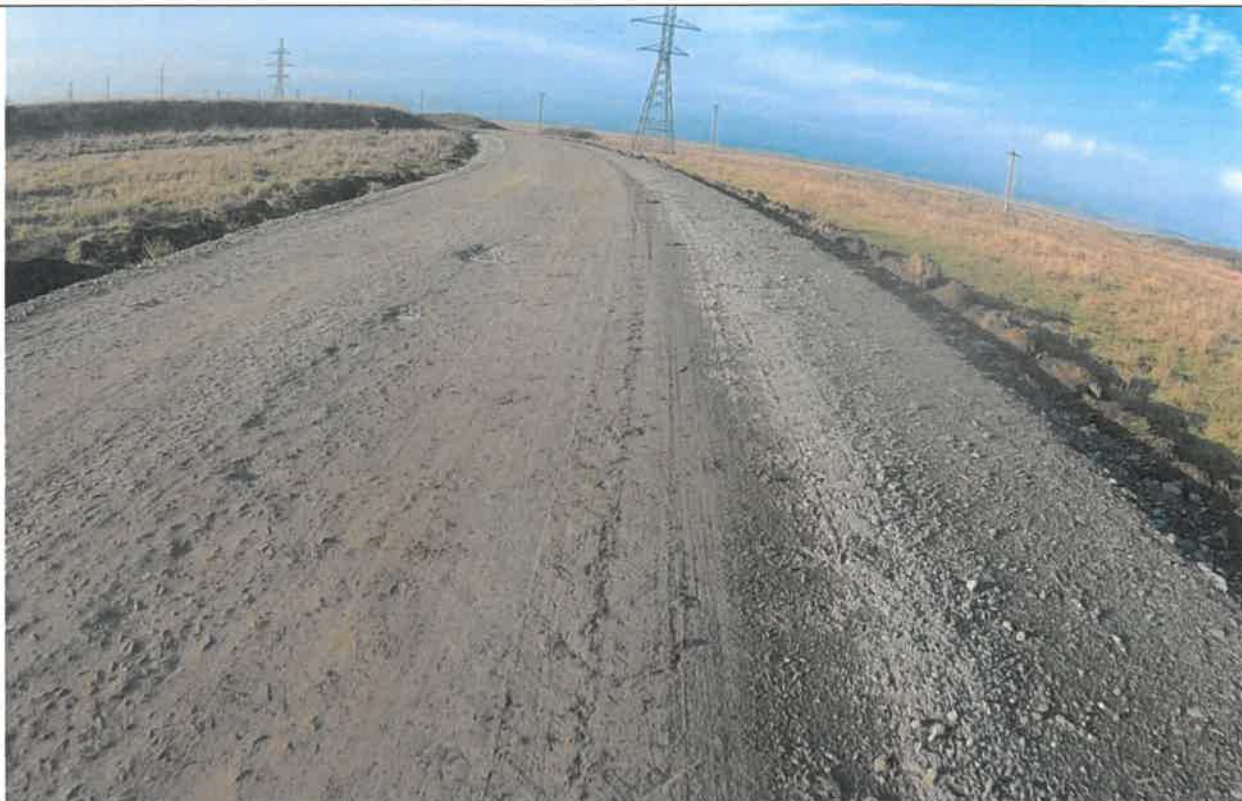
Foto 7: Drumul Național DN 28G km 17+674 – 19+695 – Pe sectorul analizat se constată prezența unui strat rutier din piatra sparta neuniform, cu tasări locale și denivelări longitudinale material granular dispersat neuniform și zone cu pierdere de agregate.
