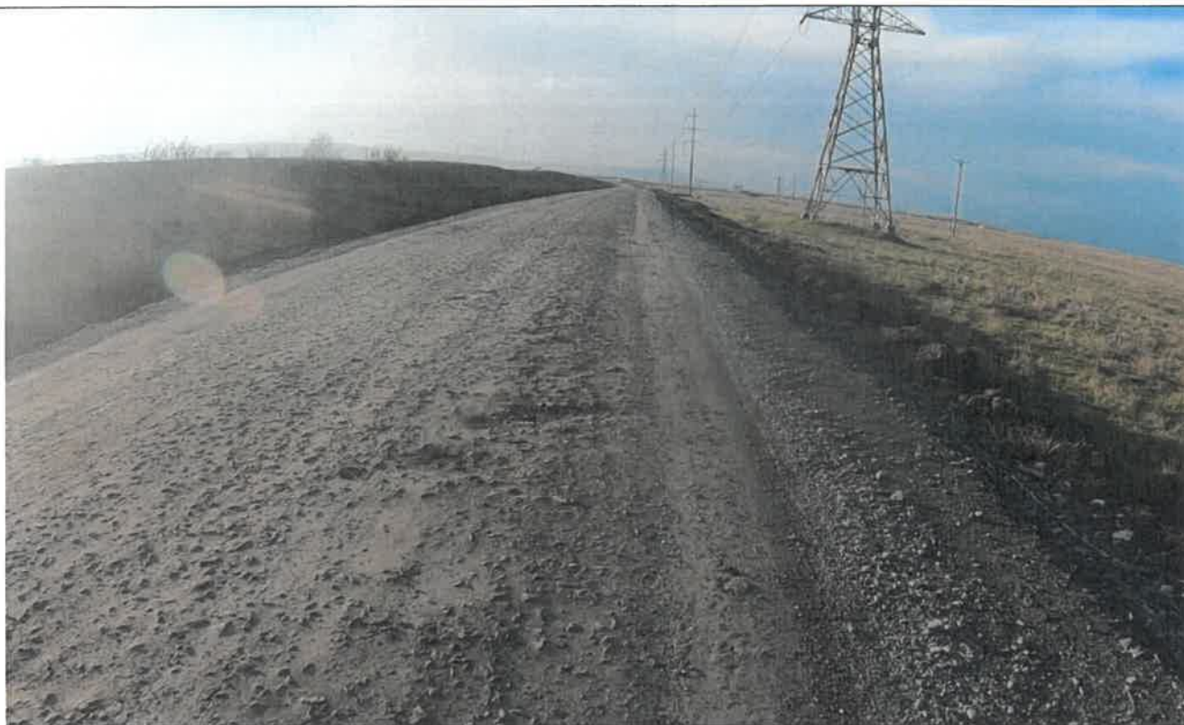
Foto 9: Drumul Național DN 28G km 17+674 – 19+695 – Pe zona de final a tronsonului analizat drumul național se prezintă în profil mixt (cu debleu pe partea stângă respectiv rambleu pe partea dreaptă). Pe sectorul analizat se constată prezența unui strat rutier din piatră spartă neuniform, cu tasări locale și denivelări longitudinale material granular dispersat neuniform și zone cu pierdere de agregate.
