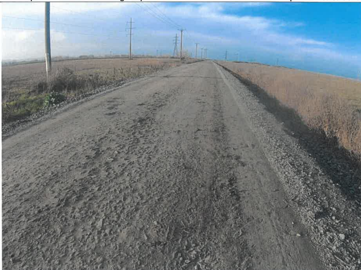
Foto 4: Drumul Național DN 28G km 17+674 – 19+695 – Drumul național se prezintă la nivel de rambleu cu înalțimi mici. Lipsa sistemelor de colectare și evacuare a apelor pluviale de la baza rambleului generează apariția vegetației implicând infiltrarea apelor pluviale în corpul taluzului.
