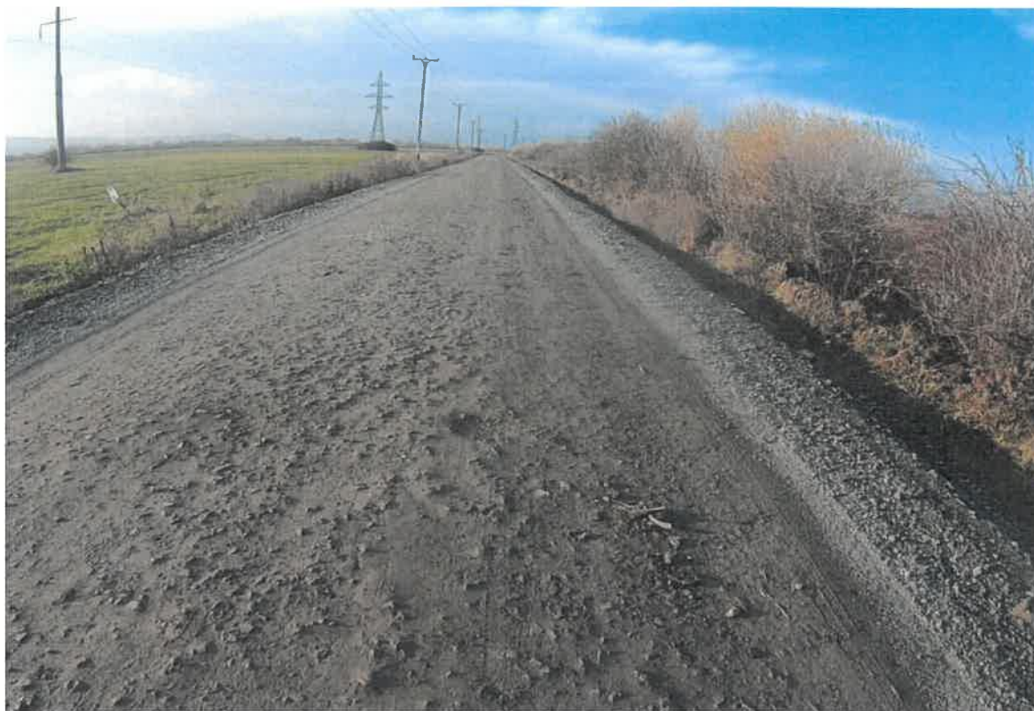
Foto 3: Drumul Național DN 28G km 17+674 – 19+695 – Pe sectorul analizat se constată prezența unui strat rutier din piatra sparta neuniform, cu tasări locale, denivelări longitudinale material granular dispersat pe acostamente. Pe partea dreapta se evidenziază o vaioaga ce prezintă diferențe de nivel semnificative raportat la calea de rulare.
