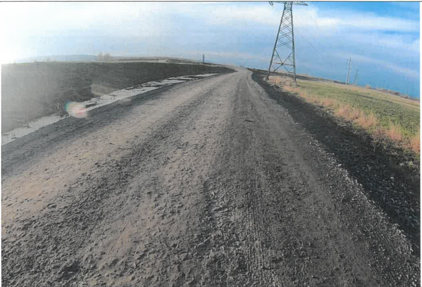
Foto 11: Drumul Național DN 28G km 17+674 – 19+695 – Pe zona de final a tronsonului analizat drumul national se prezinta in profil mixt (cu debleu pe partea stanga respectiv rambleu pe partea dreapta). A fost observată lipsa dispozitivelor de scurgere și colectare a apelor din precipitații pe unele porțiuni ale drumului, iar cele existente sunt colmatate fapt ce favorizează acumularea și infiltrarea apei în terasament.
