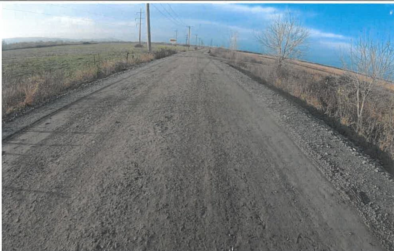
Foto 1: Drumul Național DN 28G km 17+674 – 19+695 – Pe sectorul analizat se constată prezența unui strat rutier din piatra sparta neuniform, cu tasări locale, denivelări longitudinale material granular dispersat pe acostamente. Pe partea dreapta se evidenziază o vaioaga ce prezintă diferențe de nivel semnificative raportat la calea de rulare.
