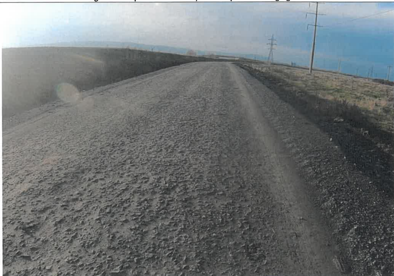
Foto 10: Drumul Național DN 28G km 17+674 – 19+695 – Pe zona de final a tronsonului analizat drumul național se prezintă în profil mixt (cu debleu pe partea stângă respectiv rambleu pe partea dreaptă). Pe sectorul analizat se constată prezența unui strat rutier din piatră spartă neuniform, cu tasări locale și denivelări longitudinale material granular dispersat neuniform și zone cu pierdere de agregate.
