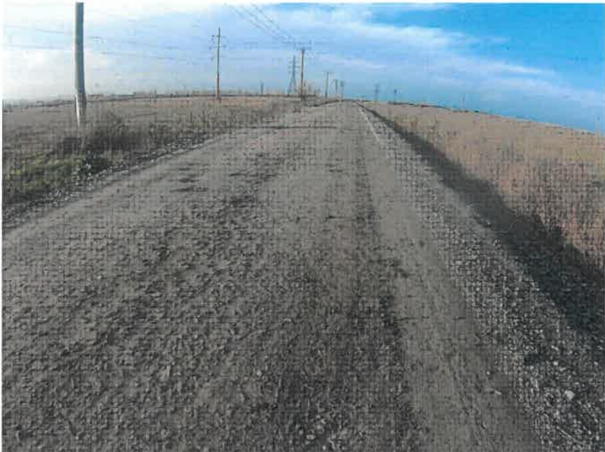
Foto 4: DN 28G Km 18+350 Drumul national se prezinta la nivel de rambleu cu inaltimi mici. Lipsa sistemelor de colectare si evacuare a apelor pluviale de la baza rambleului genereaza aparitia vegetatie implicit infiltrarea apelor pluviale in corpul taluzului.
