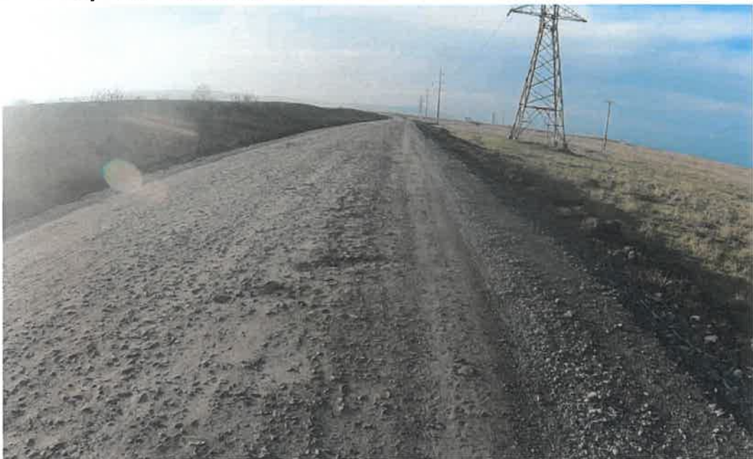
Foto 9: DN 28G KM 19+250 Pe zona de final a tronsonului analizat drumul national se prezinta in profil mixt (cu debleu pe partea stanga respectiv rambleu pe partea dreapta). Pe sectorul analizat se constată prezența unui strat rutier din piatra sparta neuniform, cu tasări locale si denivelări longitudinale material granular dispersat neuniform și zone cu pierdere de agregate.
