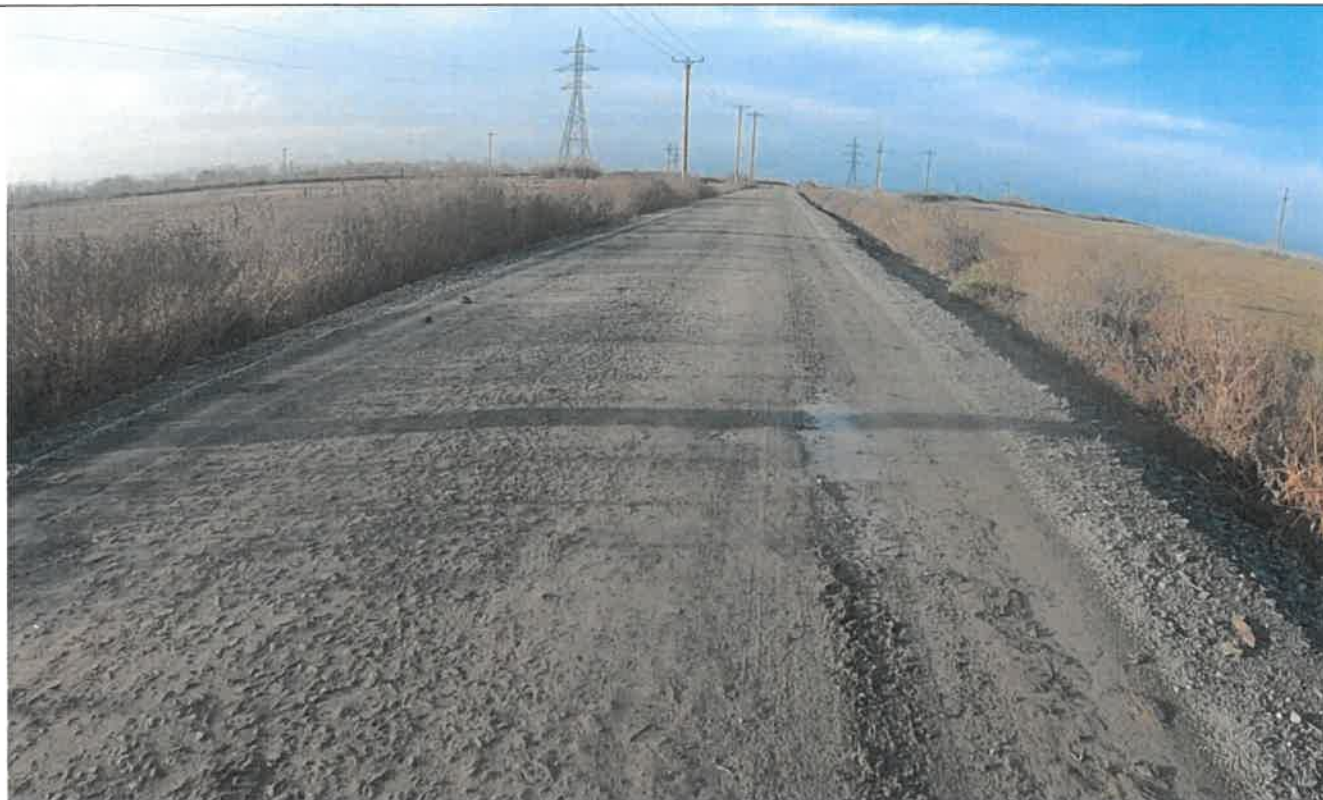
Foto 5: Drumul Național DN 28G km 17+674 – 19+695 – Drumul national se prezinta la nivel de rambleu cu inaltimi mici. Lipsa sistemelor de colectare si evacuare a apelor pluviale de la baza rambleului genereaza aparitia vegetatie implicit infiltrarea apelor pluviale in corpul taluzului.
