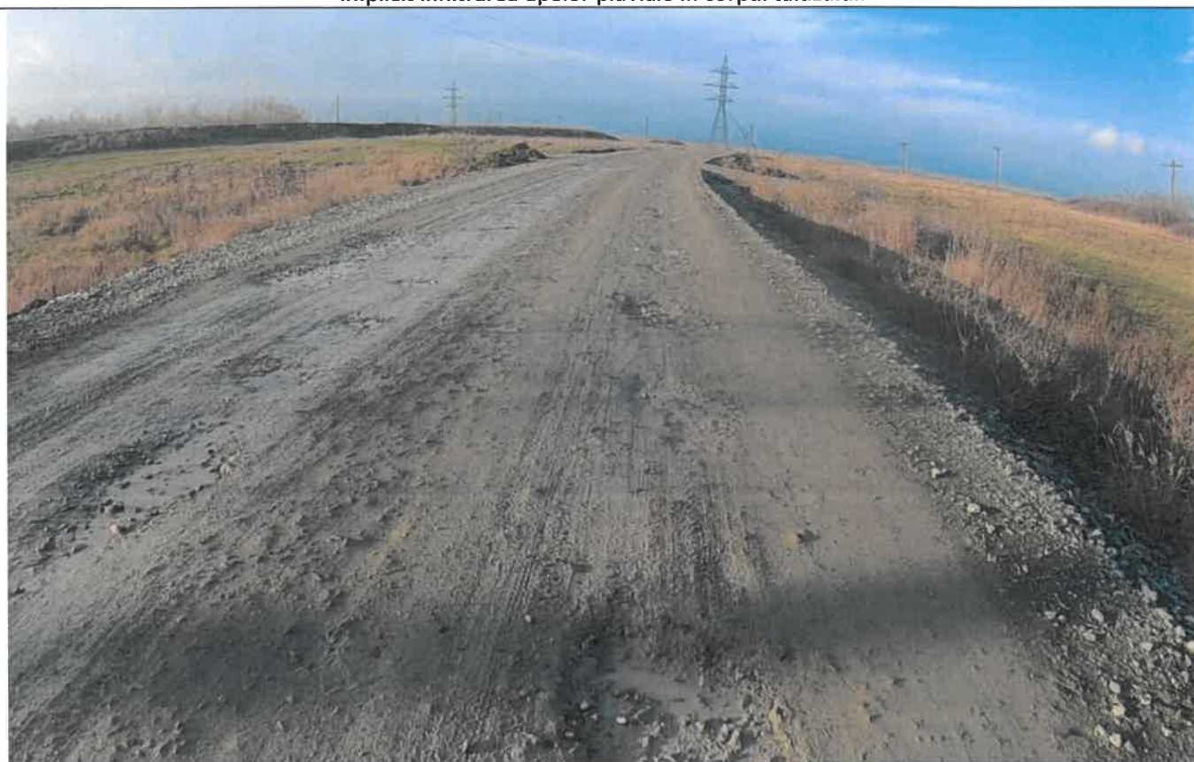
Foto 6: Drumul Național DN 28G km 17+674 – 19+695 – Drumul national se prezinta la nivel de rambleu cu inaltimi mici. Lipsa sistemelor de colectare si evacuare a apelor pluviale de la baza rambleului genereaza aparitia vegetatie implicit infiltrarea apelor pluviale in corpul taluzului. Degradarile identificate la nivelul caii de rulare sunt specifice drumurilor din materiale granulare (gropi, denivelari longitudinale, fagase etc.)
