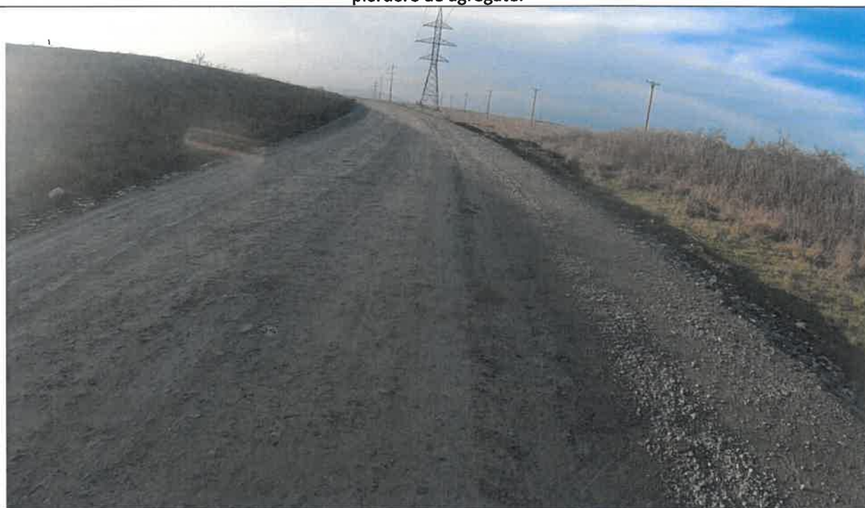
Foto 8: Drumul Național DN 28G km 17+674 – 19+695 – Pe sectorul analizat se constată prezența unui strat rutier din piatra sparta neuniform, cu tasări locale și denivelări longitudinale material granular dispersat neuniform și zone cu pierdere de agregate.
